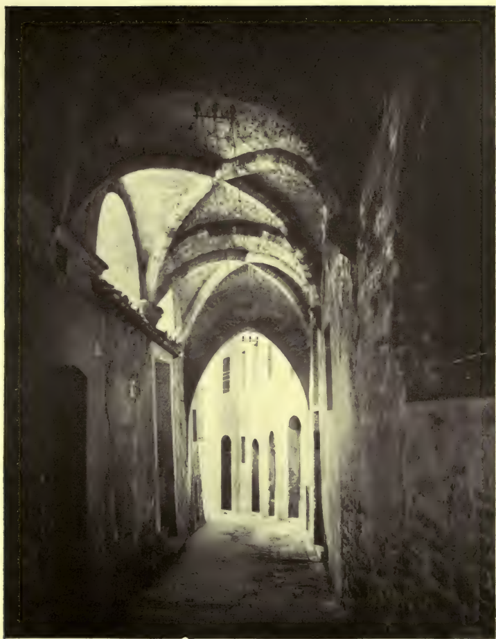
VIA DELLE STALLE
